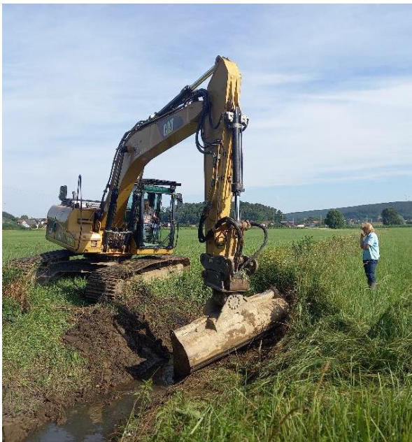
Aufweitung der Uferböschung durch Anlage von Bermen
